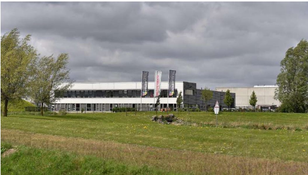
La société Reprocolor, qui jusqu'alors se trouvait à Lille, s'est installée à Hallennes-lez-Haubourdin en 2012. Son vaste bâtiment est emblématique de la zone du Moulin-Lamblin. Photo Florent Moreau - VDNPQR
